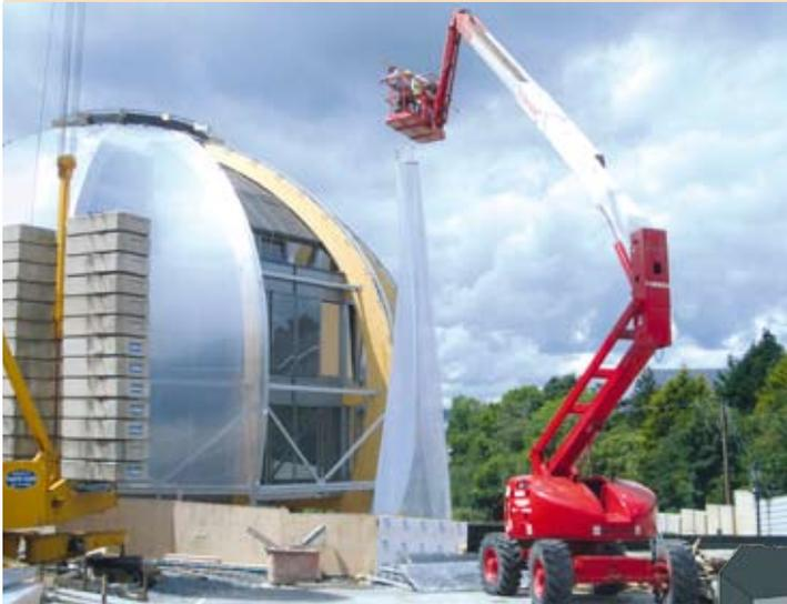
Über die gebogenen Spanten wurde eine teflonartige Hightexmembran gespannt, hinter der sich nach Fertigstellung eine energieeffiziente, moderne Fassade befindet.
